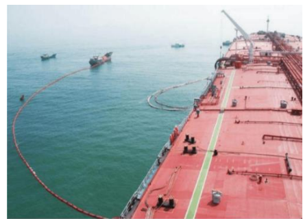
30 万吨级油码头单点系泊系统
