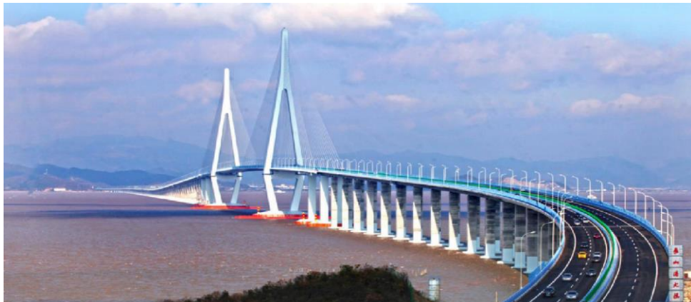
宁波象山港大桥结构健康监测咨询（主跨 688 米）
