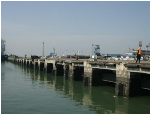
新港港务公司五、六区泊位改造工程
